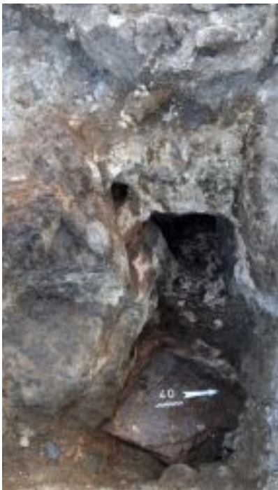
Une canalisation creusée dans la pierre, en bon état de conservation a été découverte dans la partie un peu plus au nord de la tranchée. Elle servait à amener l'eau de pluie des toits du château dans la tour Nord-est qui contenait une citerne.
