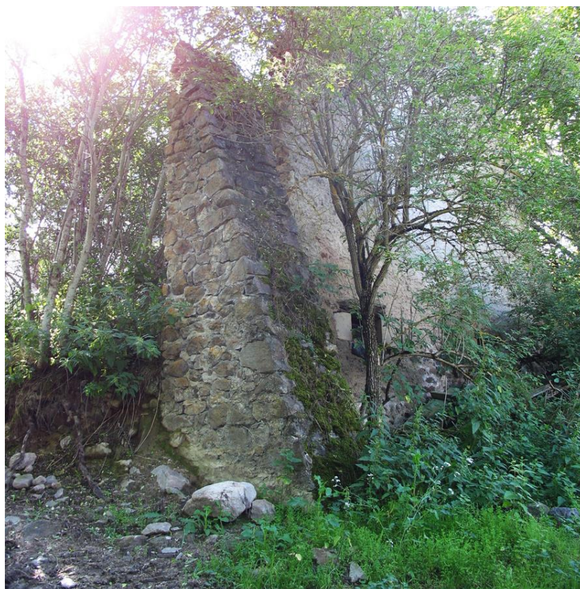
Contrefort et mur de la partie ancienne des bâtiments du Monteil.
