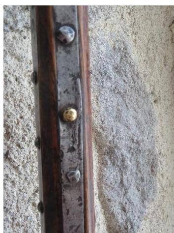
emboutit cette partie et façonne un arrondi. La partie basse a vu ses clous remplacés en bonne partie. La bague de maintien a peut-être été remplacée et fixée par une soudure verticale à l'argent.
