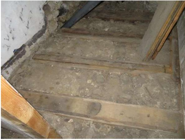
De nouveaux travaux d'installation électrique ont montré des difficultés de passer des câbles par les planchers car entre les poutres, un remplissage de pierres a ainsi comblé ces vides sous forme de voûtains. En voici un exemple découvert lors du dégagement d'un plancher d'origine en mauvais état...
