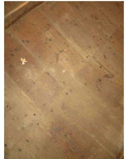
Un exemple de boiseries démontées pour traitements, suite à des problèmes d'humidité ascensionnelle. Les traces d'outils anciens et la présence de clous forgés attestent de l'ancienneté de ces boiseries qui auront servi de modèles pour des parements en suite lors d'aménagements et modifications au cours du 20<sup>e</sup> siècle.
