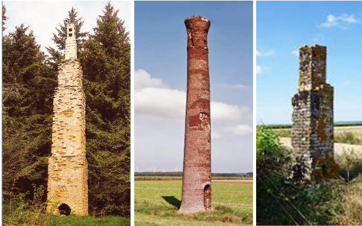
La cheminée géodésique de Bar (à gauche) et deux autres édifices de mêmes destinations.
