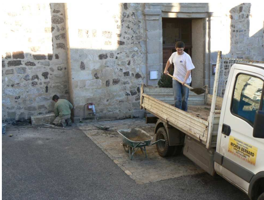
La mise en place.
