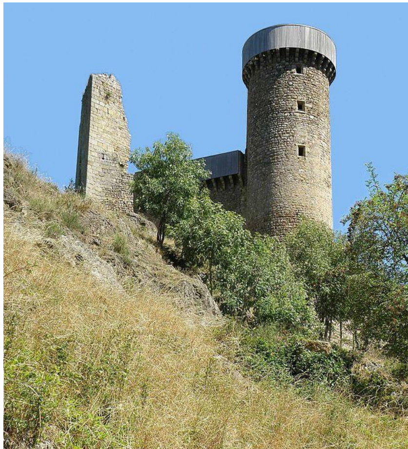
Les deux grandes tours ( circulaire et triangulaire ), avec la courtine qui les relie, vues depuis l'ouest.
