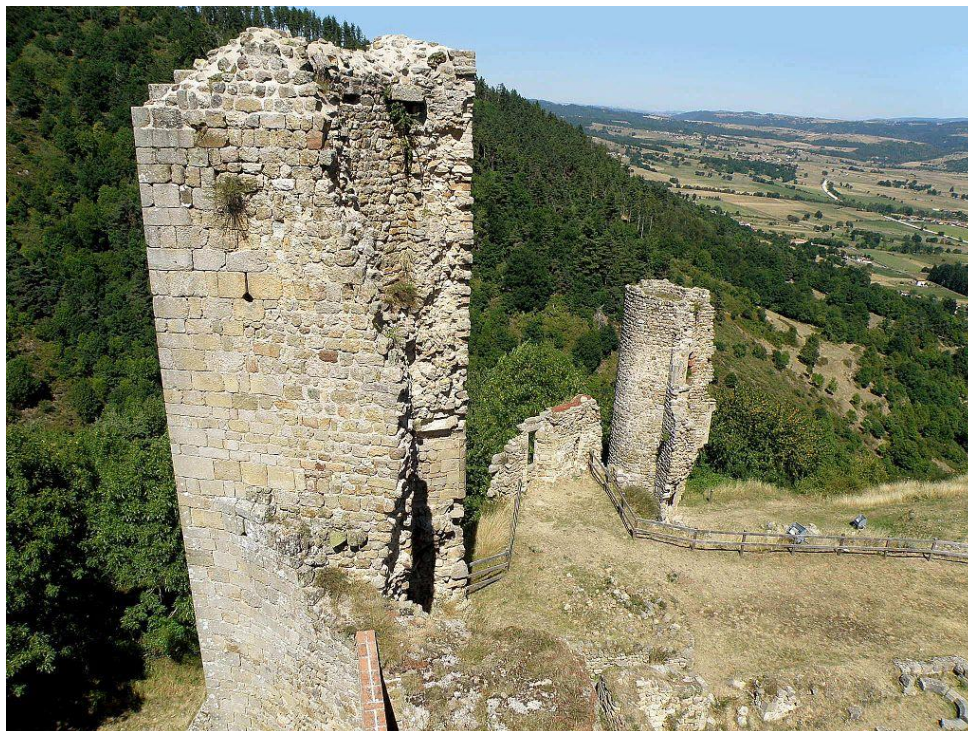
La tour triangulaire vue du sommet de la tour ronde.
